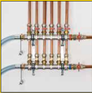
Spoelen van radiatorsystemen en wand-/ vloerverwarmingen (S/SL/SLW)
