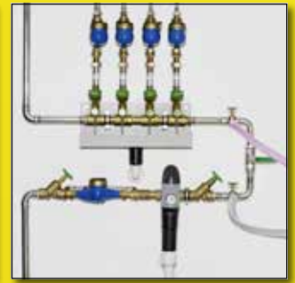
Spoelen van drinkwaterinstallaties (S/SL/SLW)
