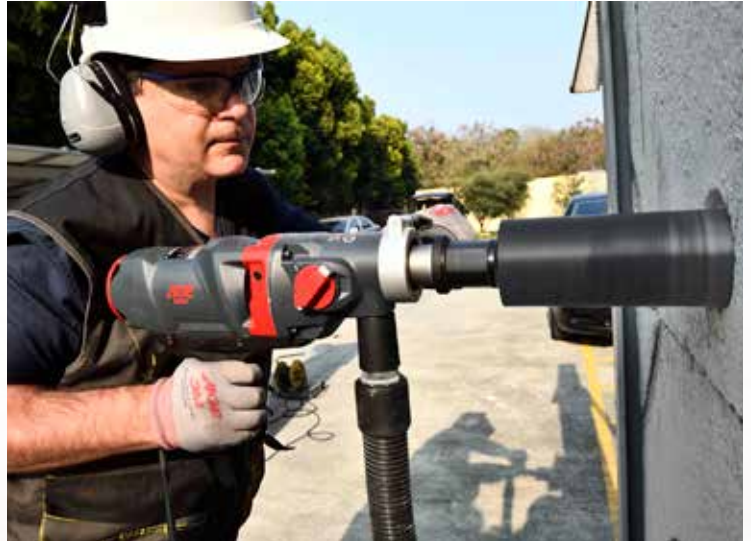
Diamantboorkronen geschikt voor droog gebruik in (gewapend) beton
